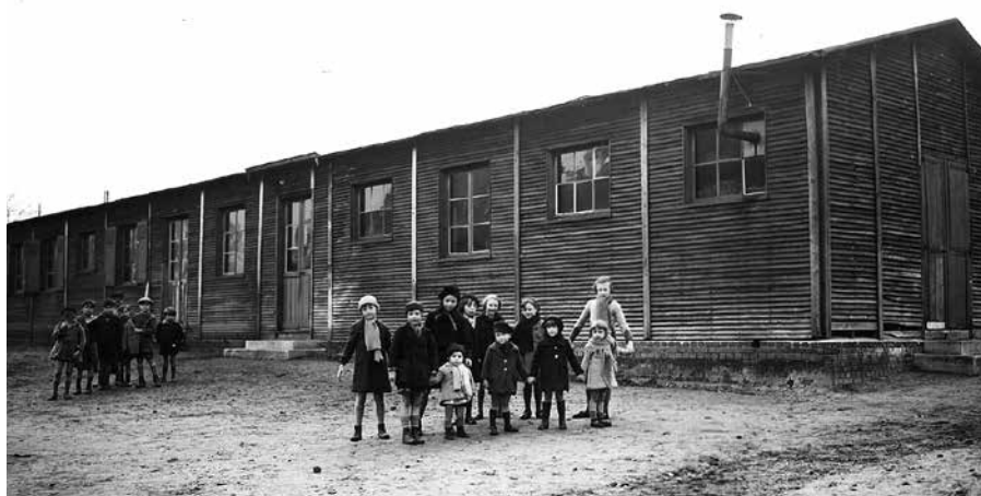
Baraquements provisoires servant de salles de classe. 20 février 1939. (Archives municipales, cote 1,27 m 2 )
