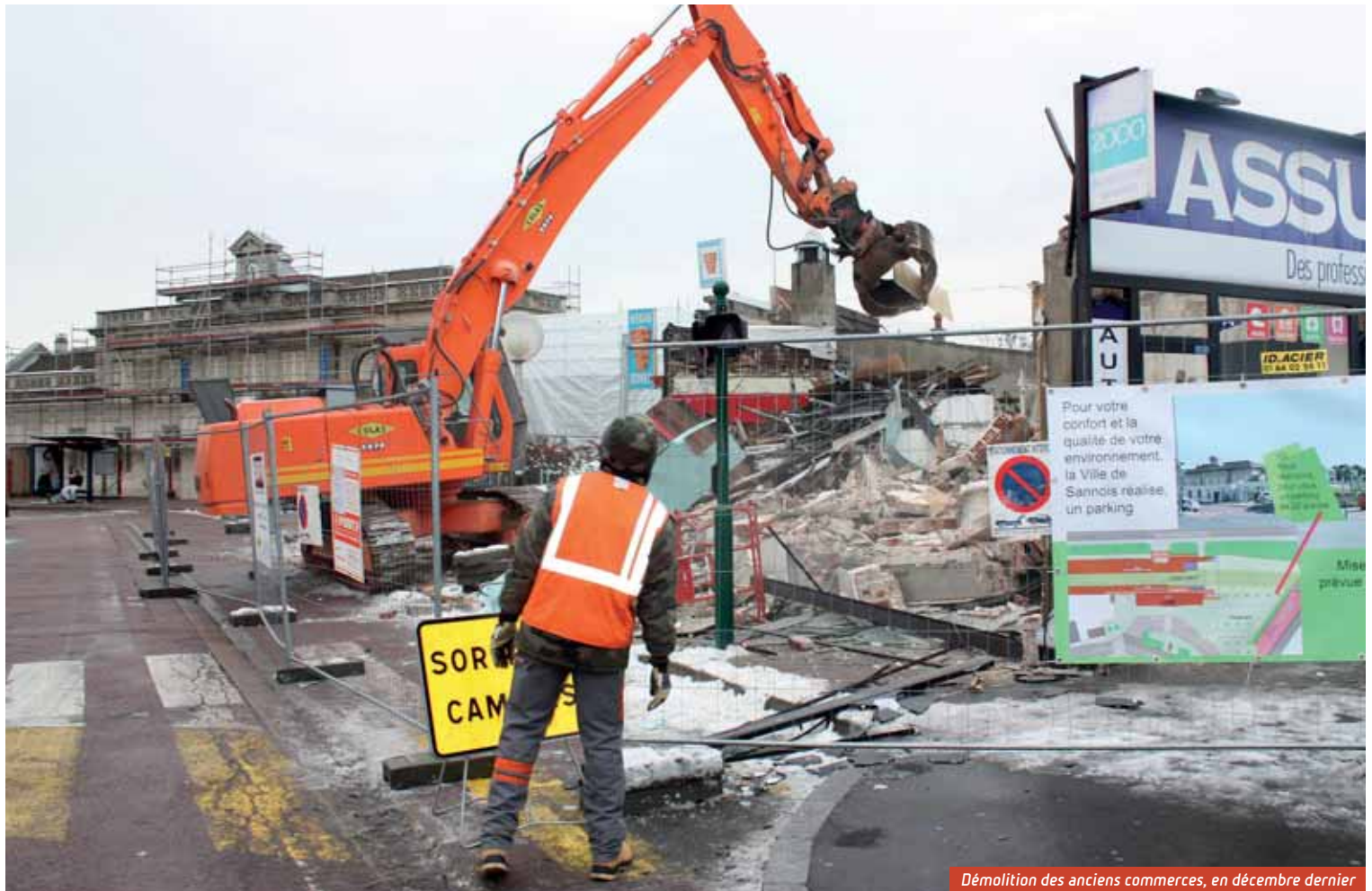
Démolition des anciens commerces, en décembre dernier
